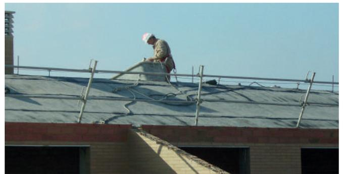
Quando no pueda eliminarse el riesgo, las medidas a tomar deben ir encaminadas a **reducir el riesgo de caída, adoptando medidas de protección colectiva**, mediante el uso de andamios, plataformas elevadoras, instalación de barandillas, redes de seguridad, etc.
